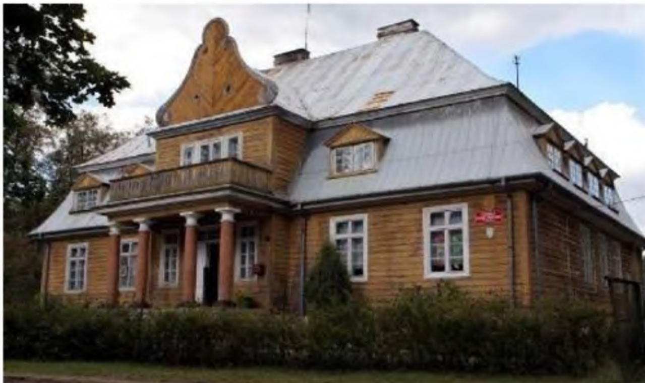
Zdjęcie 1. Obiekt dworku w Przystani przed remontem
