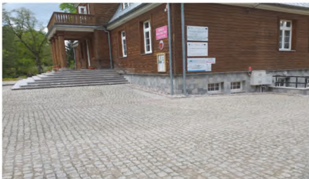
Zdjęcie 5. Obiekt dworku w Przystani po remoncie przyziemia w 2019 roku
