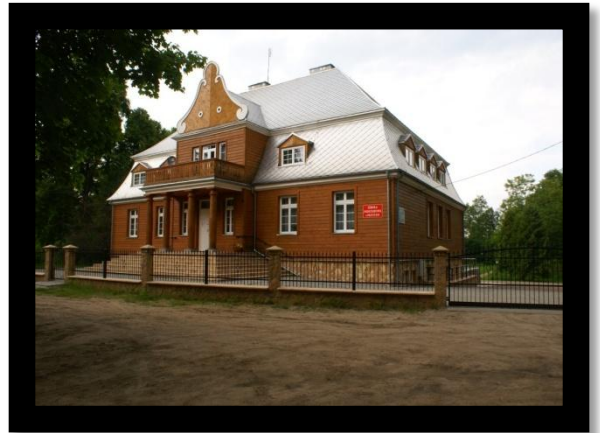
Zdjęcie 2. Obiekt dworu w Przystani po remoncie
