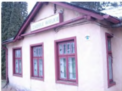
Fotografia 9 Przestrzeń zdegradowana – Stacja PKP Zabiele Wielkie
