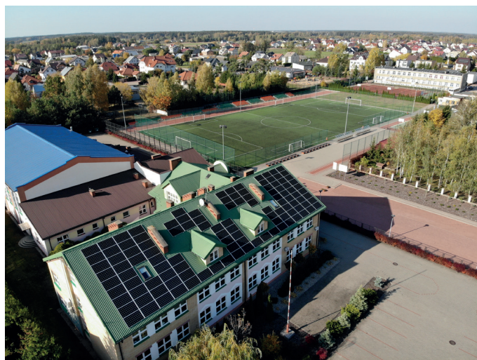
Budynek Szkoły Podstawowej w Olszewie-Borkach
