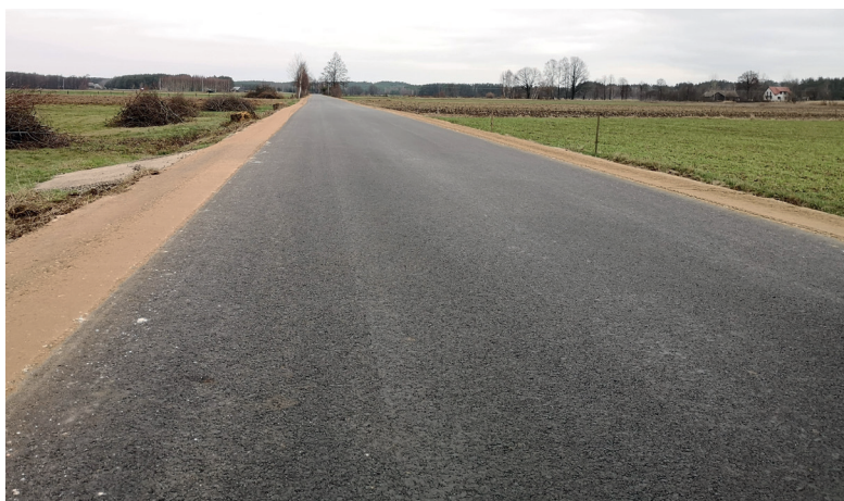
Droga gminna w miejscowości Żebry-Perosy
